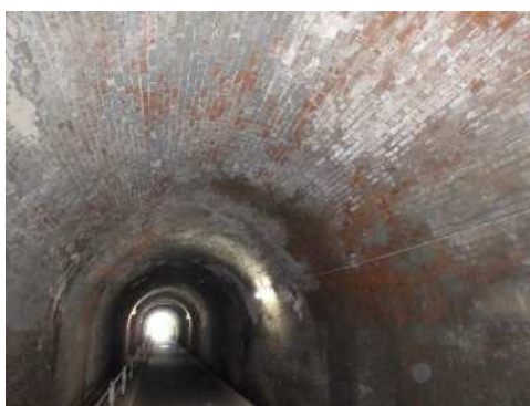
写真 2-4 その他（レンガ工法） （鳥羽山洞門）
