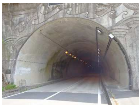
写真 2-1 NATM 工法 （豆こぼしトンネル）
