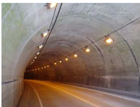
写真 2-2 矢板工法 （大川トンネル）
