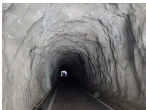
写真 2-3 その他（吹付工法） （大島第 1 隧道）
