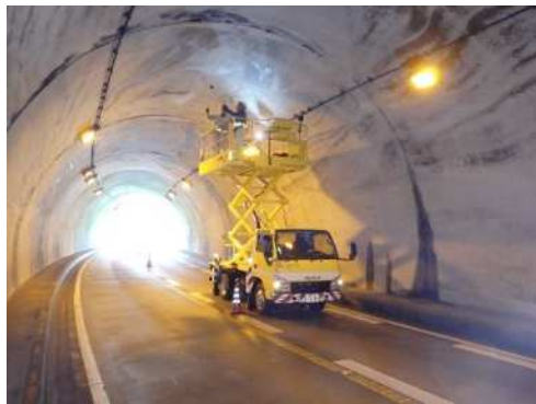
写真 2-5 トンネル点検車による近接目視点検
