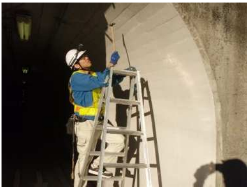
写真 2-6 梯子による近接目視点検
