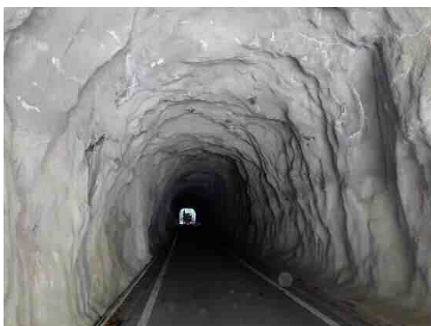
写真 2-3 その他（吹付工法） （大島第 1 隧道）
