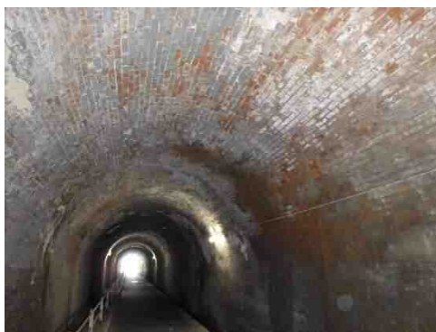
写真 2-4 その他（レンガ工法） （鳥羽山洞門）
