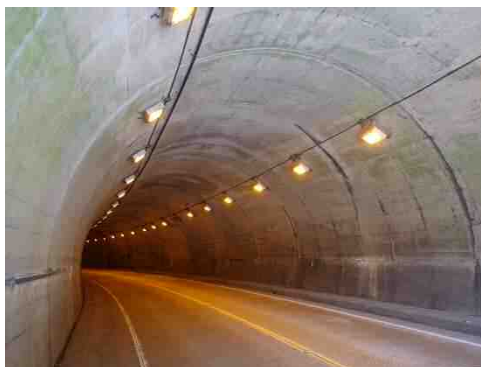
写真 2-2 矢板工法 （大川トンネル）
