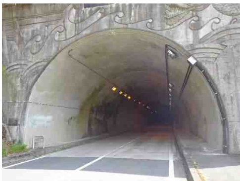
写真 2-1 NATM 工法 （豆こぼしトンネル）
