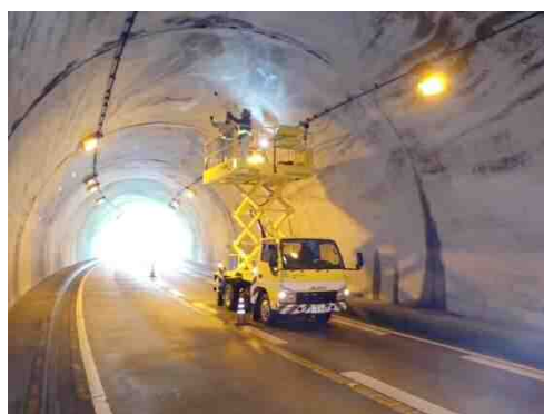
写真 2-5 トンネル点検車による近接目視点検
