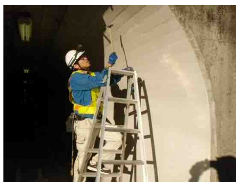
写真 2-6 梯子による近接目視点検
