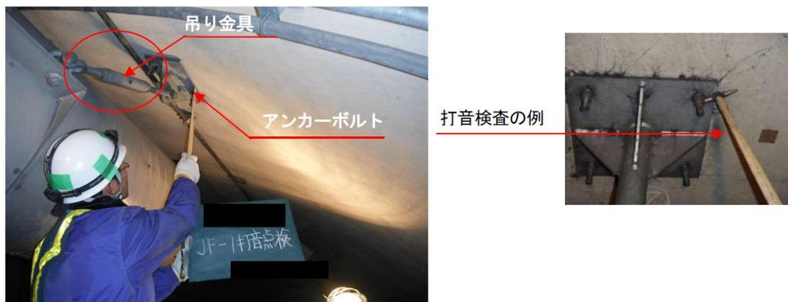
写真-解 6.3 打音検査作業状況（附属物）
