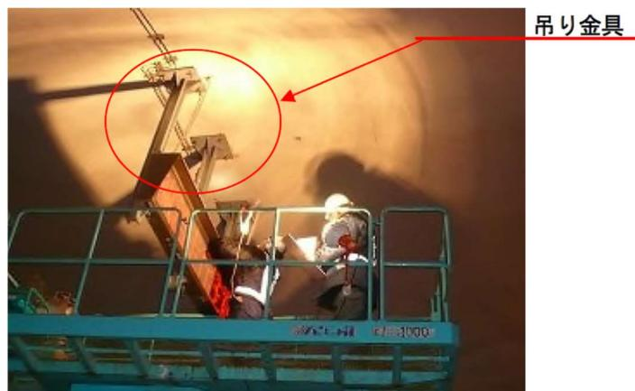
写真-解 6.4 触診作業状況
