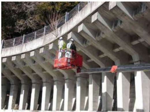
写真 2-6 高所作業車による近接目視点検
