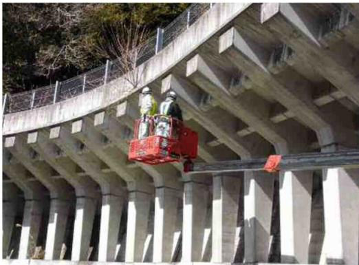
写真 2-6 高所作業車による近接目視点検
