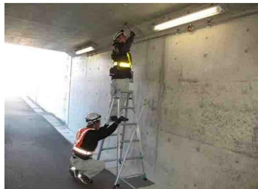
写真 2-7 梯子による近接目視点検
