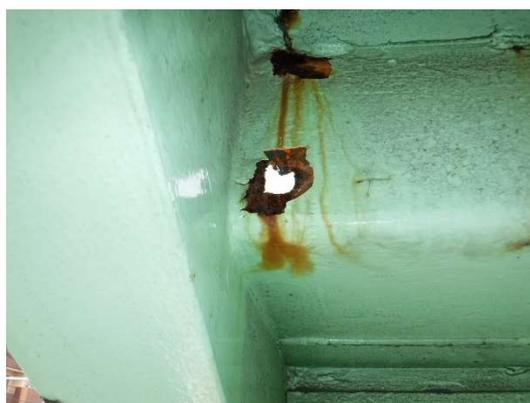
写真4 階段部の腐食による孔食
