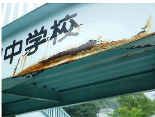
写真3 損傷事例（主桁の変形）
