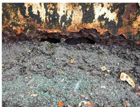
写真 3-2 区分Ⅱの損傷例
