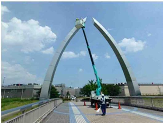
写真 2-4 高所作業車による近接目視点検
