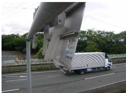
写真 3-1 区分Ⅲの損傷例 （標識板の変形）
