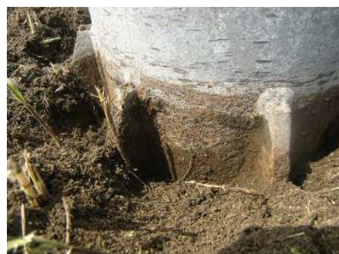
写真 2-4 支柱基部（路面境界部）の点検
