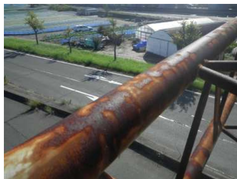
写真 3-2 区分Ⅱの損傷例 （横梁の腐食）
