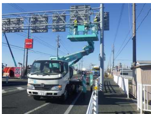
写真 2-3 高所作業車による近接目視点検
