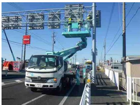
写真 2-3 高所作業車による近接目視点検
