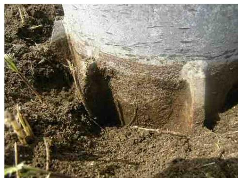
写真 2-4 支柱基部（路面境界部）の点検
