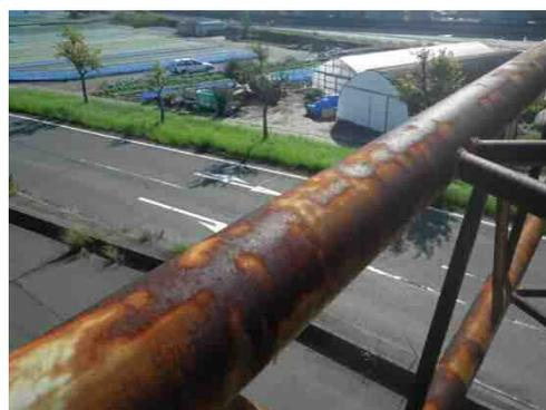
写真 3-2 区分Ⅱの損傷例
