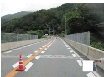
浮き上がりが無いか確認する
