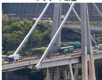
コンクリート被覆
