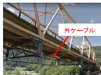
鋼橋の外ケーブル補強の例
