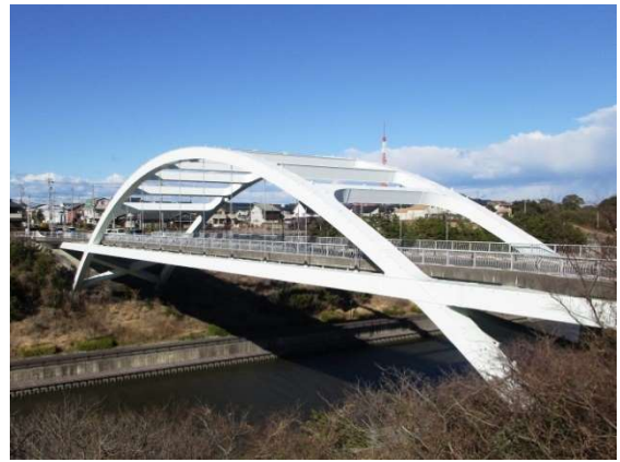
【アーチ橋】大平大橋（市道大平台 4 号線）
