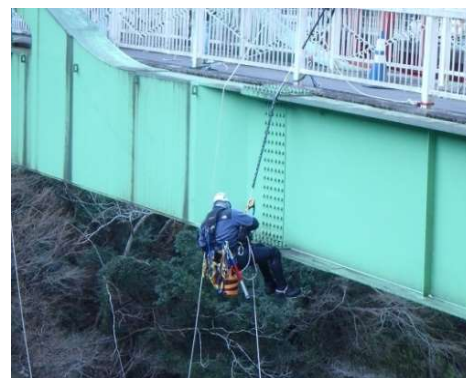
写真 2-5 ロープを用いた近接目視点検
