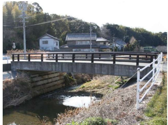
【床版橋】源太橋（市道神ヶ谷 208 号線）
