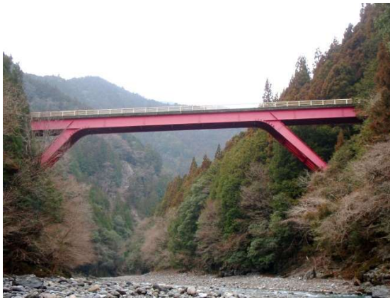
【ラーメン橋】小休戸橋（市道佐久間横吹 38 号線）
