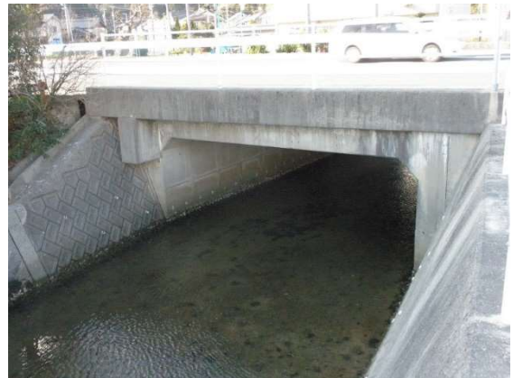
【溝橋】岩根橋 BOX 橋（国道 362 号）
