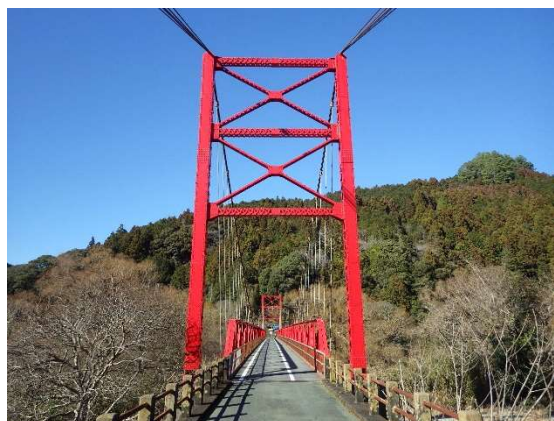
【その他（吊橋）】気田川橋 1（県道大輪天竜線）
