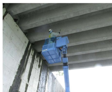
写真 2-3 高所作業車による近接目視点検
