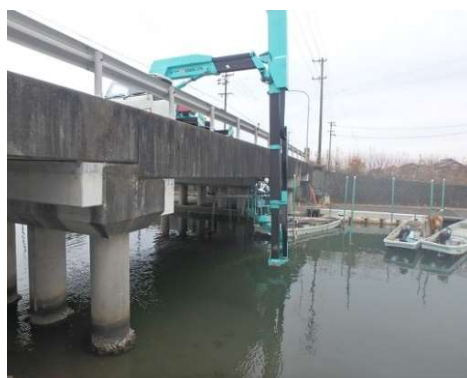
写真 2-2 橋梁点検車による近接目視点検
