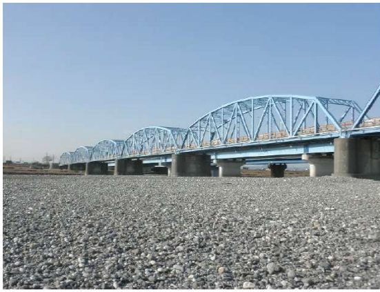
【トラス橋】天竜川橋（県道磐田細江線）
