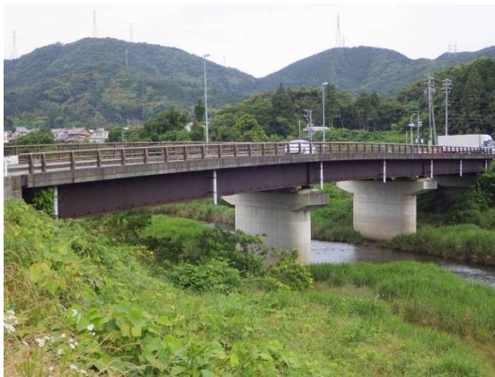
【桁橋】藤渕橋（国道 362 号）
