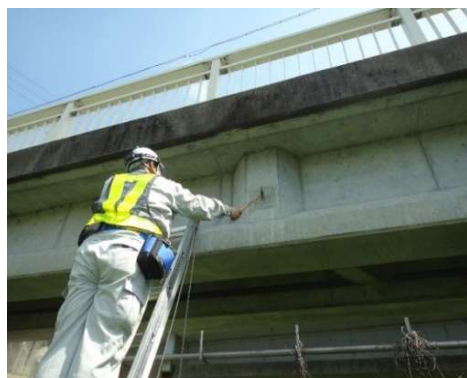
写真 2-4 梯子による近接目視点検
