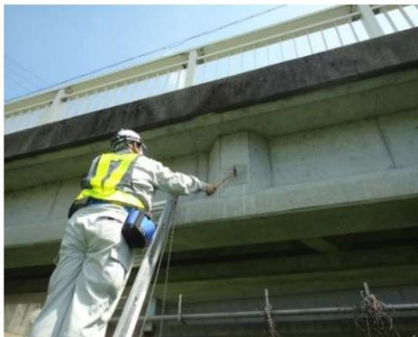
写真 2-4 梯子による近接目視点検
