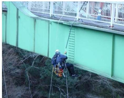
写真 2-5 ロープを用いた近接目視点検
