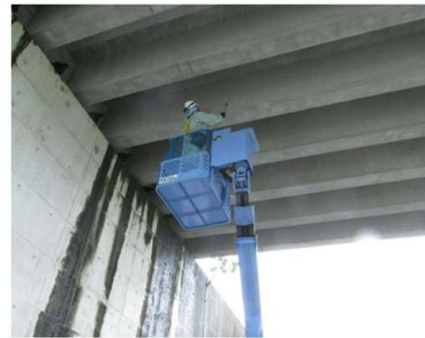
写真 2-3 高所作業車による近接目視点検
