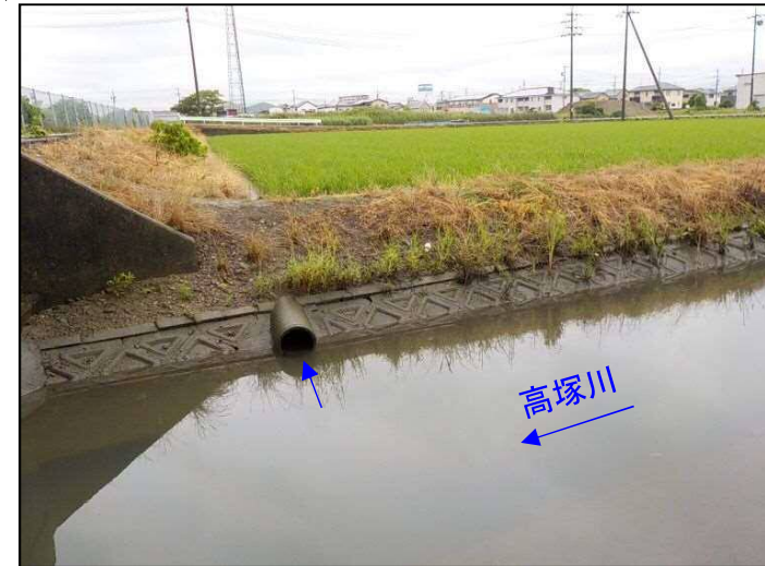
高塚川の水位を上昇させて、水田へ水を引く。
