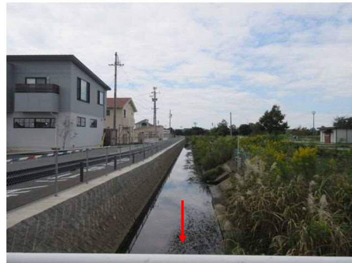
② 下流側より篠原15号排水路を望む
