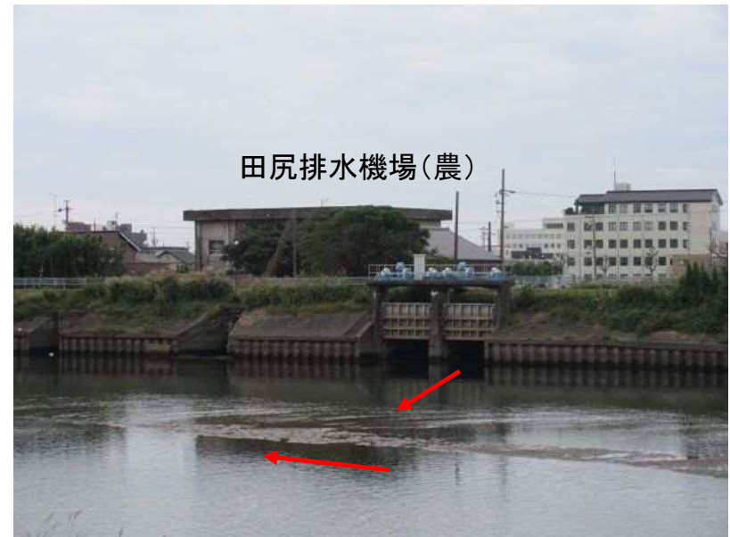
② 馬込川左岸側より合流部を望む
