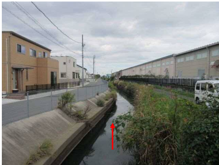
① 上流側より下流を望む
