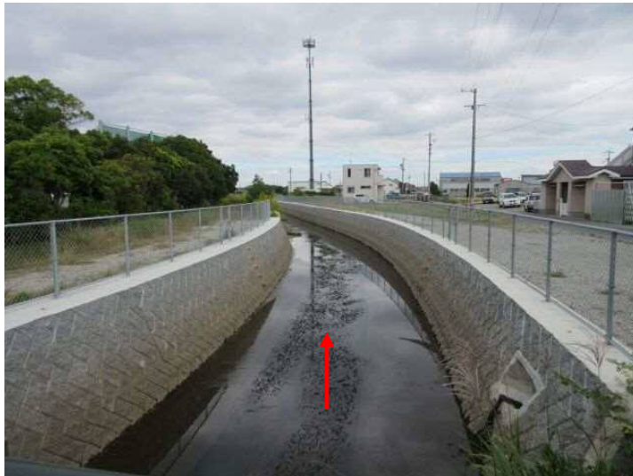
① 上流側より下流を望む
