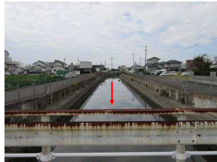
② 下流側より上流を望む
