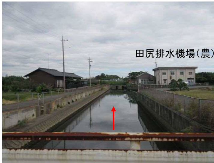
① 上流側より合流部を望む
