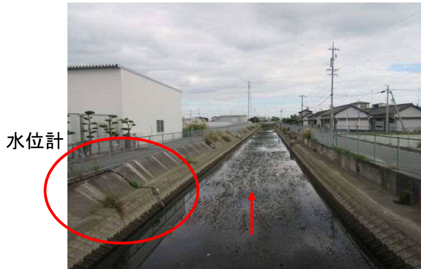
① 上流側より下流を望む
