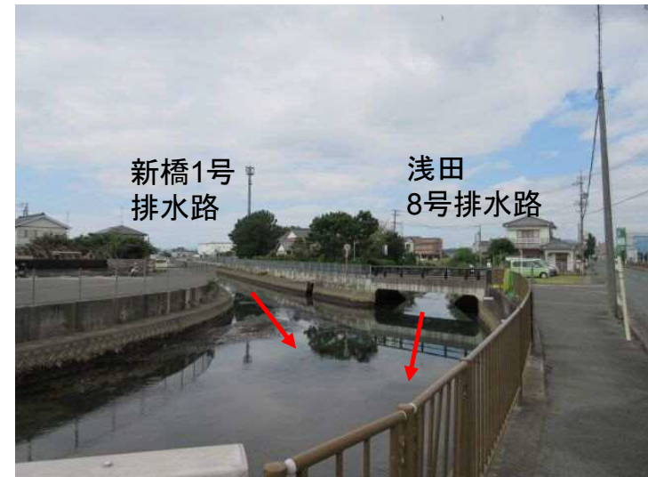
② 下流側より上流を望む
