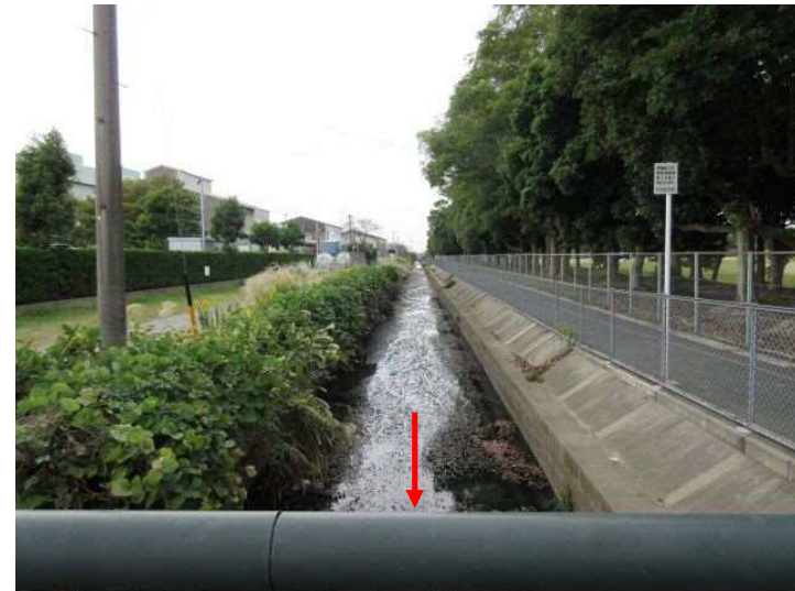
② 下流側より上流を望む
