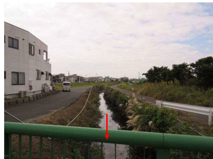
② 下流側より上流を望む
