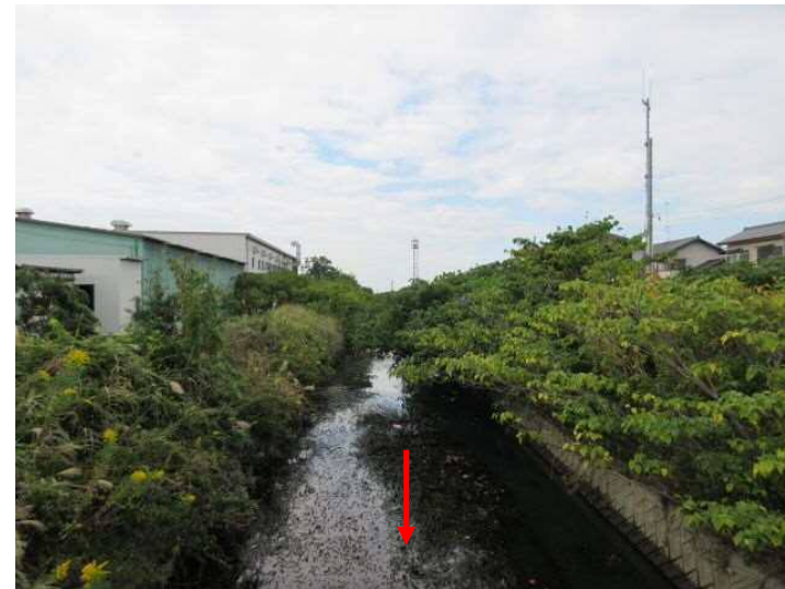
② 下流側より上流を望む
