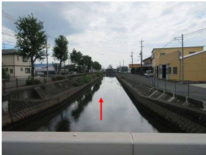
① 上流側より合流部を望む
