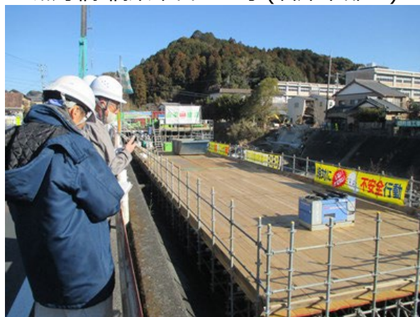
しょうげつばし 嘯月橋 橋梁架替え工事(右岸下部工)
