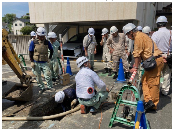
和合町外地内老朽管更新工事
