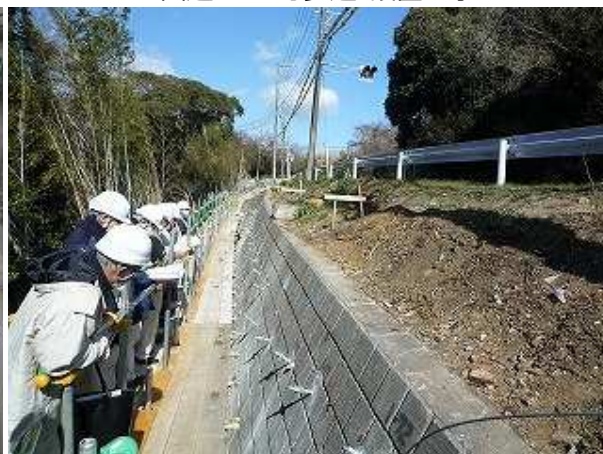
国道 257 号歩道 設置工事
