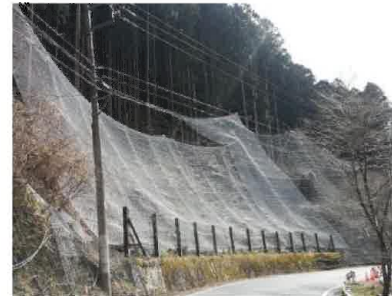
▲道路斜面对策の状況
