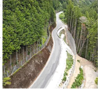
▲国道 152 号(池島～大原)の状況
