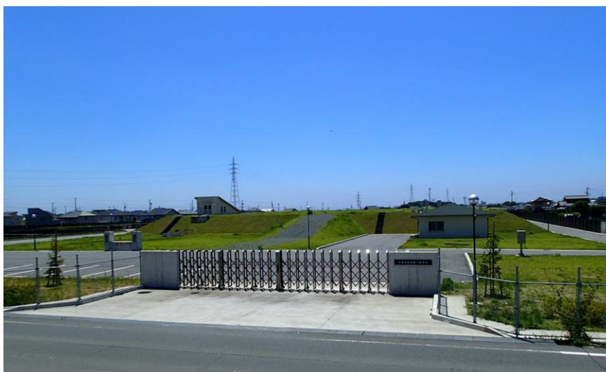
図 4.7.1 耐震性を有する大原浄水場第 5 配水池
