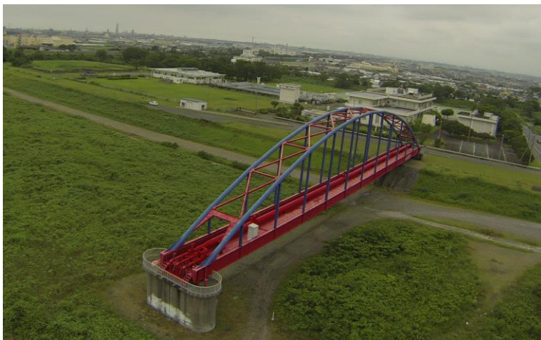
天竜川伏流水の取水施設と導水管（水管橋） 最大取水能力・・・34,900 m 3 /日
