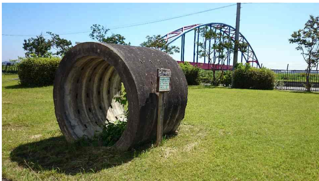
図 4.7.2 天竜川から取水する常光浄水場の集水埋管の見本（手前）と導水水管橋（奥）
