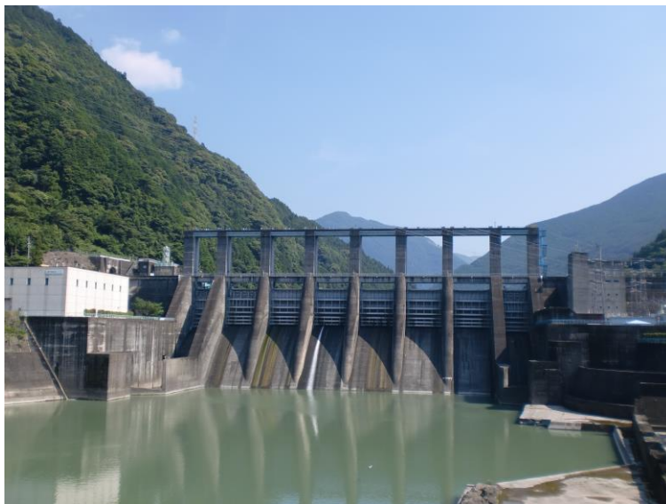
天竜川表流水の取水場所（秋葉ダム） 最大取水能力・・・105,500 m 3 /日
