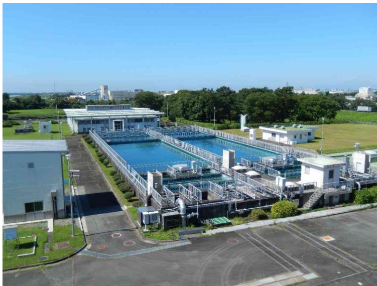
処理能力・・・50,000 m 3 /日 配水方法・・・ポンプ圧送 浄水処理方式・・・凝集沈でん急速ろ過方式
