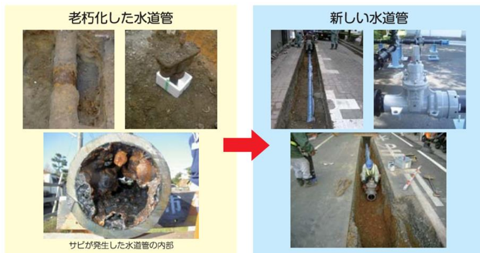
図 4.5.1 老朽管の更新
