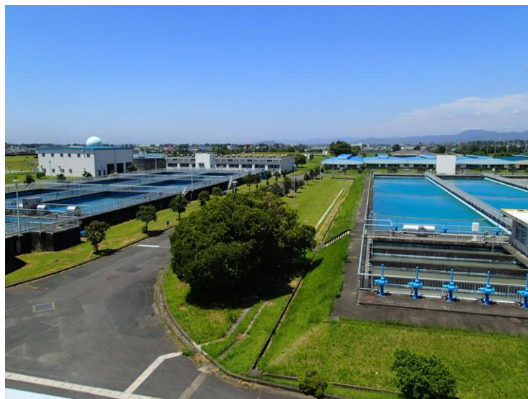
処理能力・・・150,000 m 3 /日 配水方法・・・自然流下（標高 71 メートル） 浄水処理方式・・・凝集沈でん急速ろ過方式
