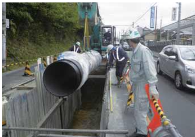
図 2.3.2 基幹管路の耐震化（布設替え）
