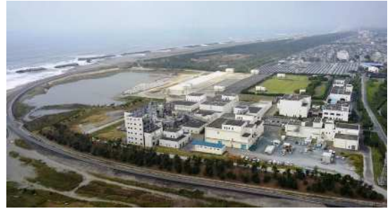
西遠浄化センター
