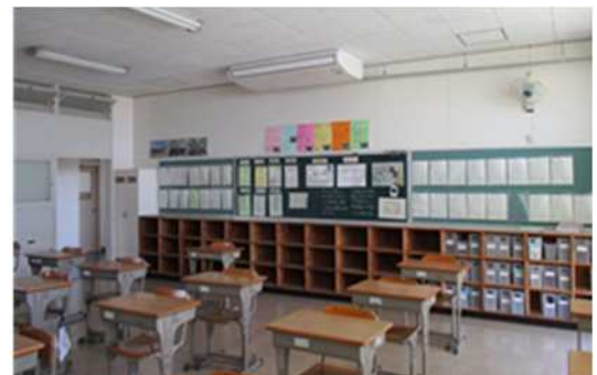
市立小中学校空調設備
