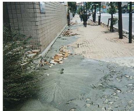
液状化による被害例
