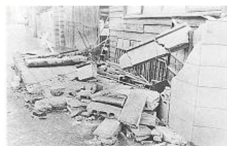
宮城県沖地震におけるブロック塀倒壊による被害例（出典：仙台市HP）
