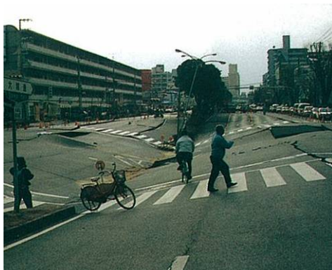
道路の沈下による被害例
