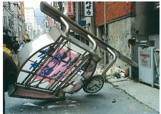
屋外物の落下による被害例
