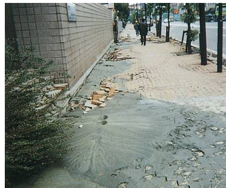
液状化による被害例
