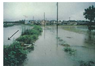
安間川沿いの浸水被害状況(下石田町)
