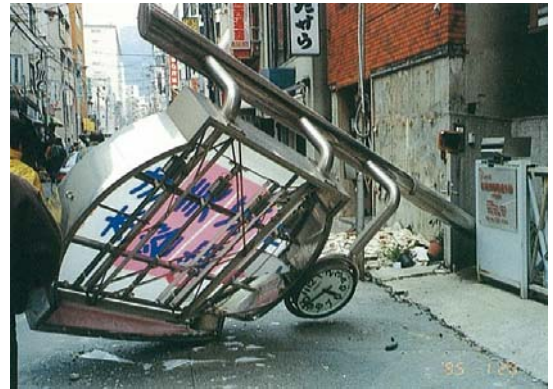
屋外物の落下による被害例
