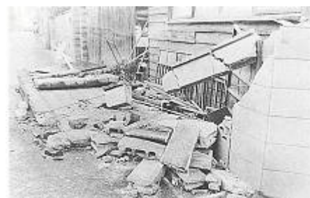
宮城県沖地震におけるブロック塀倒壊による被害例（出典：仙台市HP）
