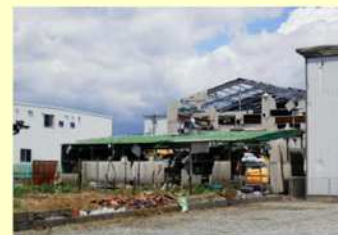
⑤ 屋根や外壁が飛散した工場 (南東方向から撮影)
