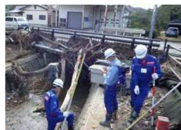
岩手県久慈市北の越川 被災状況調査
