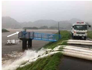
排水ポンプ車の稼働状況(三島市御園地区)
