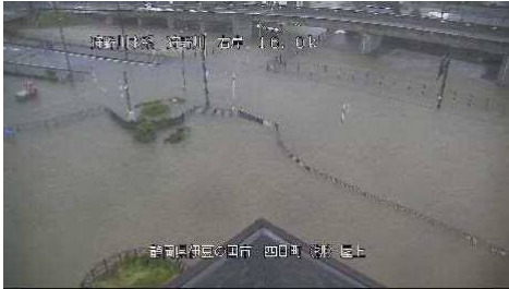
四日町地区の浸水状況(静岡県伊豆の国市)
