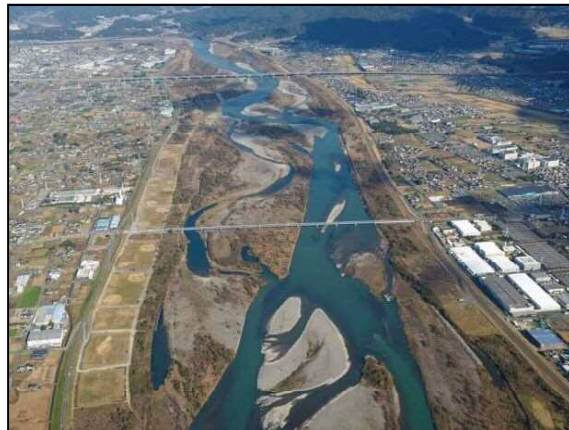
河道内の樹木繁茂状況(天竜川中瀬・広瀬地区)
