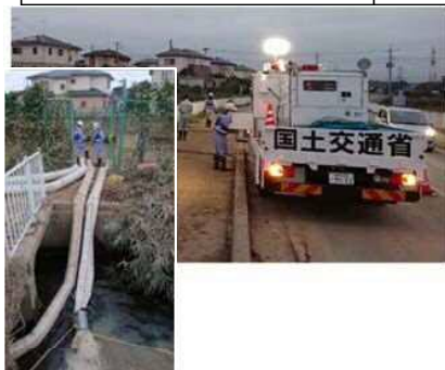
埼玉県坂戸市 排水作業
