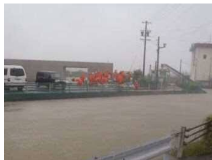
水防団や災害協定業者による土嚢製作(静岡県菊川市)
