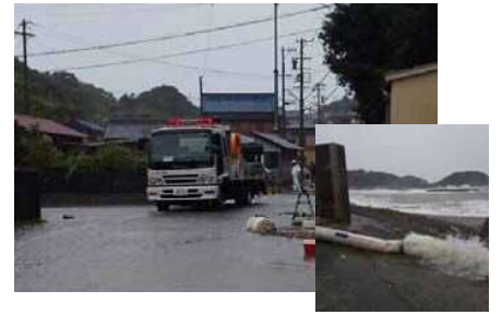
排水ポンプ車の稼働状況(三重県志摩市大王町)
