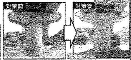
橋梁の耐震補強 (橋脚巻き立て・落橋防止システム)
