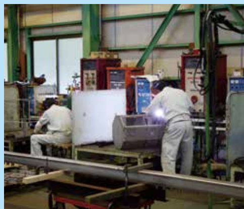
溶接作業風景
