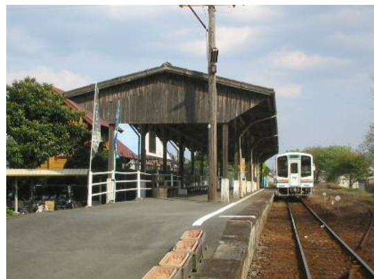
気賀駅上屋及びプラットホーム
