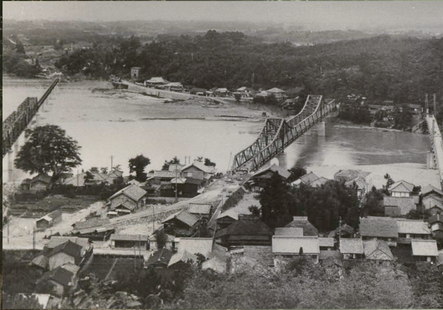
▲鳥羽山より俯瞰する鹿島橋(昭和10年代)
