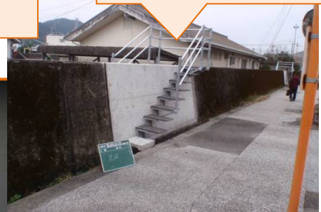
コンクリートによる封鎖
