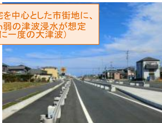
沿道は低層住宅が中心
