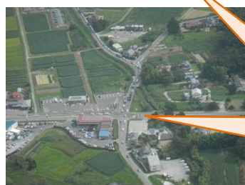
県防災ヘリコプターによる上空からの渋滞箇所の確認
