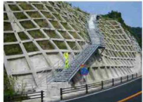
高台避難階段への手すりの設置
