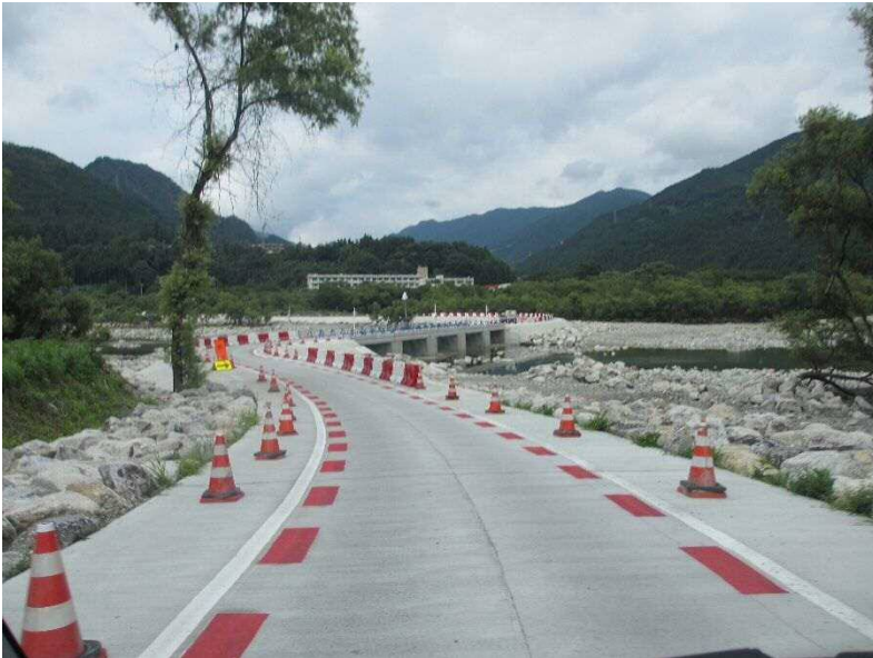
佐久間町 原田橋河川内仮設道路 撮影 月花 真澄
