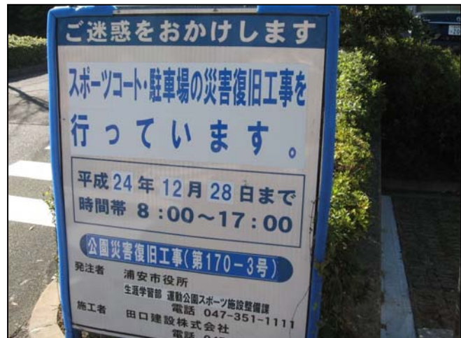
総合体育の復旧工事の看板
