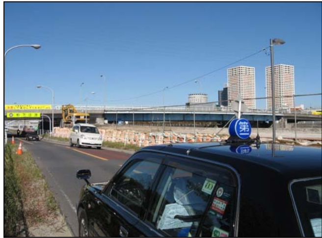
(8) 復旧工事中の美浜境川沿いの歩道の歩道
