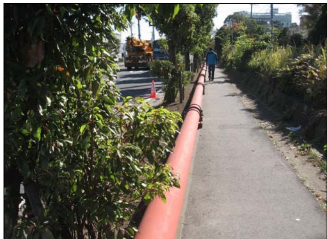
(9) 総合体育館出入口付近の下水道と思われ仮設配管
