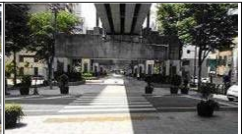
鉄道高架下を活用した開放的な歩行者空間 （中区・鍛冶町通り～万年橋）
