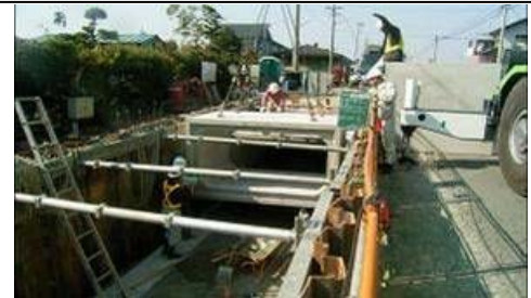
雨水処理のための都市下水道整備 (整備中)
