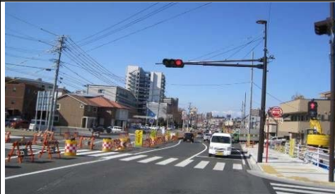
自動車交通の整流化を図る 環状線の整備（整備中）
