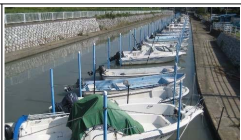
係船施設完成状況 (西区・協和排水路)
