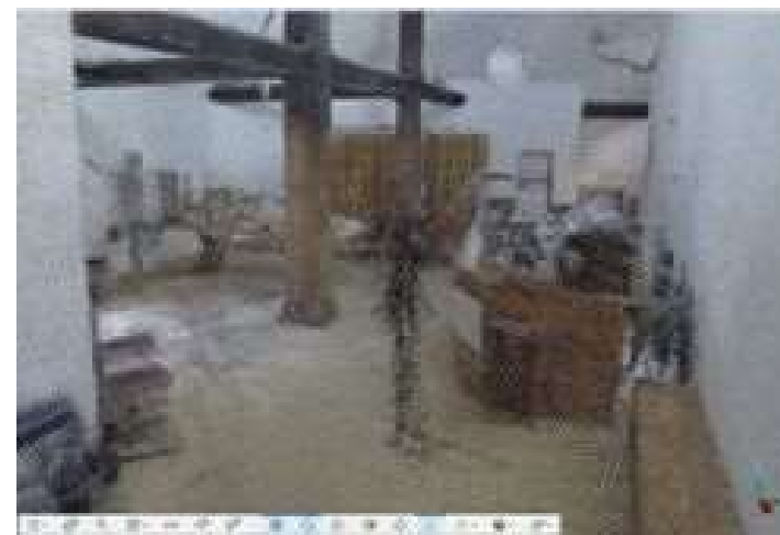
建造物の屋内形状点群データの収集結果表示例
