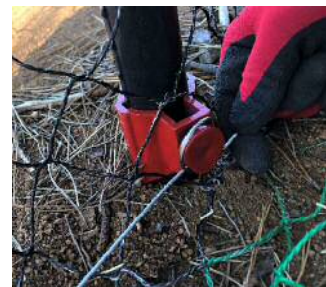
S-ONフック支柱に取り付けた場
