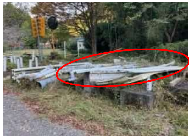
明細表⑬ 令和3年度土木施設災害復旧事業(一)鮎釣東雲名 春野線 道路災害復旧工事(3災第1号)
