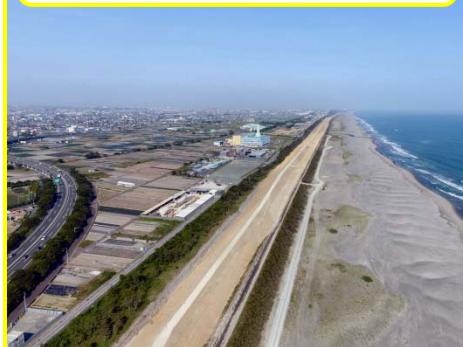
篠原4工区 平成28年5月完成
