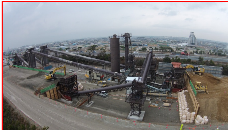
舞阪工区プラント稼働状況
