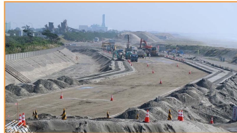
舞阪工区防潮堤築堤状況
