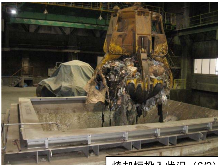
焼却炉投入状況 (6/2)
