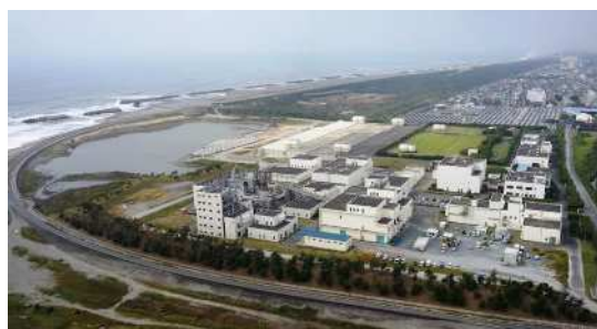
西遠浄化センター
