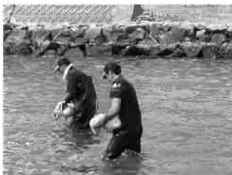
フルボ酸鉄敷設作業
