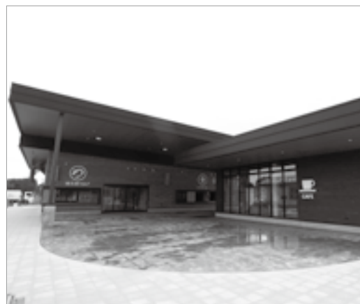
▲ 従来の3倍の広さとなる新店舗。カフェも新設
