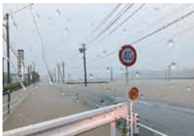
令和5年発生した豪雨による細江地区の浸水状況
