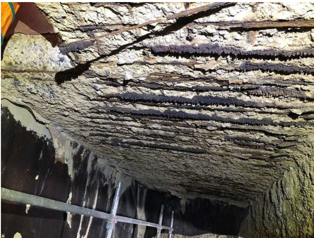
② 北面（天井）
