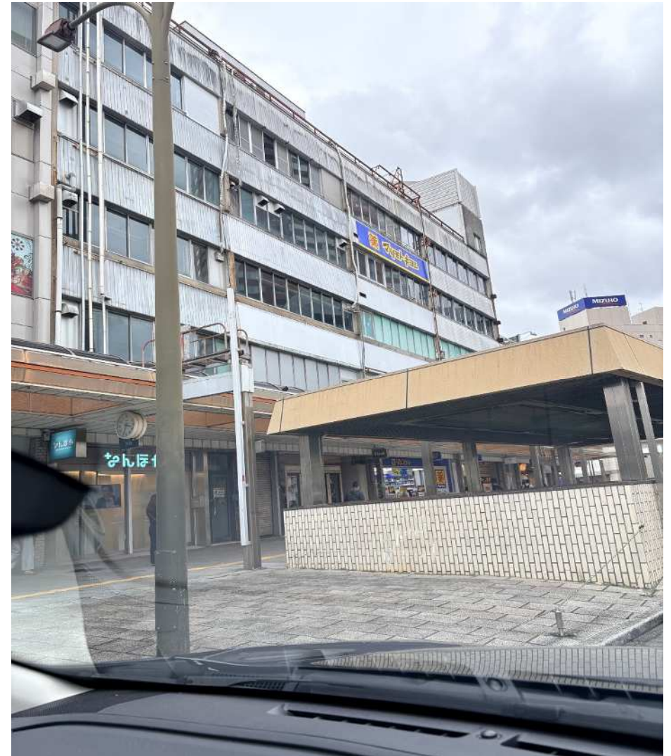
JR浜松駅北側 老朽建築物
