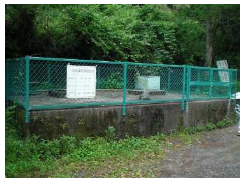
現在の春野貯留槽
