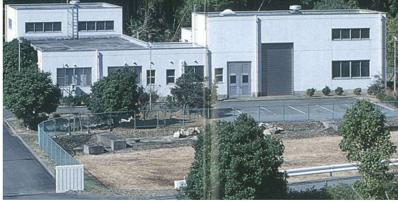
第1 浸出水処理施設
