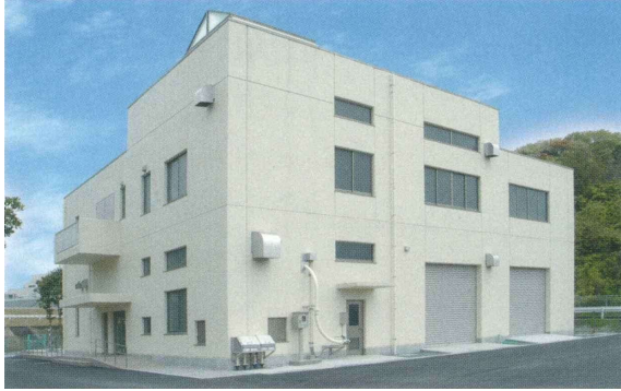
カルシウム除去・生物処理設備
