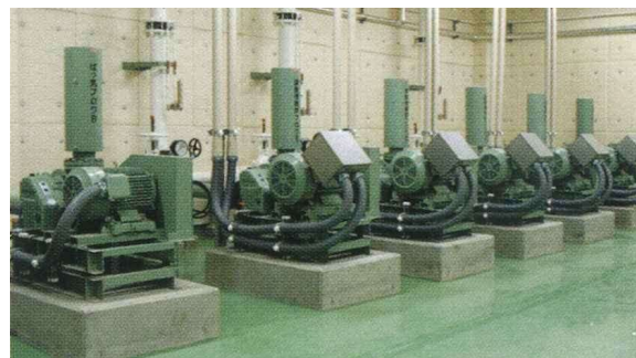
薬品注入設備
