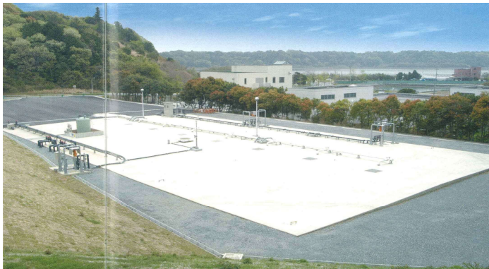
浸出水調整槽
