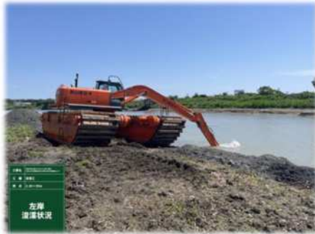
令和4年度 浚渫実施状況
