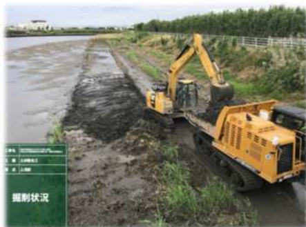
令和6年度 浚渫実施状況
