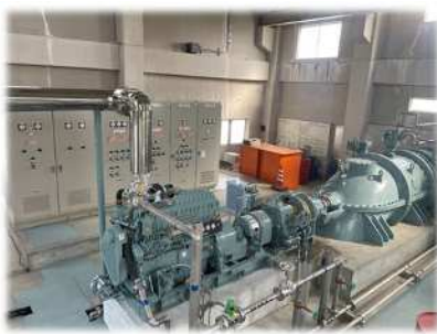
第1排水機場 1号ポンプ修繕、電気設備更新
