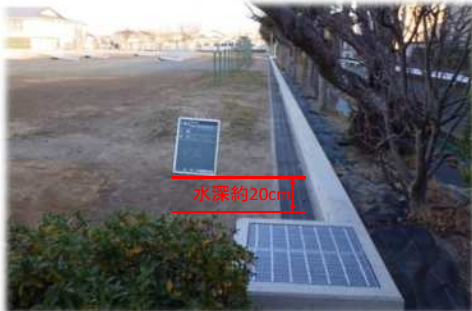
令和2年度施工箇所 (可美中学校)
