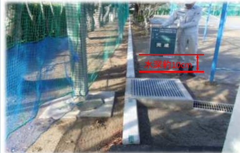
令和元年度施工箇所 (新津中学校)
