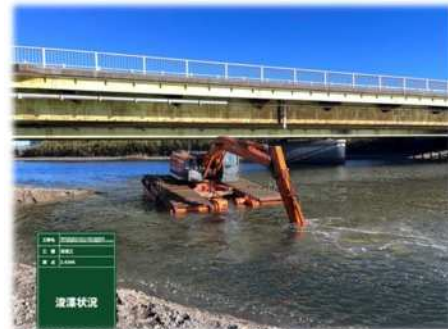
令和5年度 浚渫実施状況
