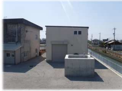
第2排水機場 吐水槽
