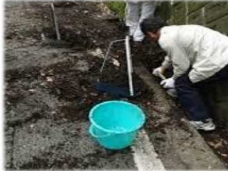
実施状況(土砂上げ)
