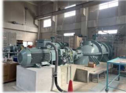
第1排水機場 2号ポンプ修繕
