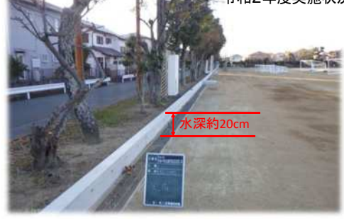
令和2年度施工箇所 (可美中学校)
