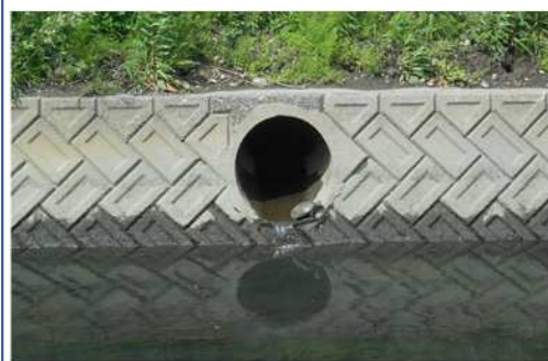
令和2年度現在状況(逆流防止施設)
