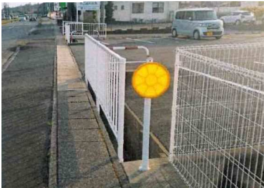
フェンスの設置
