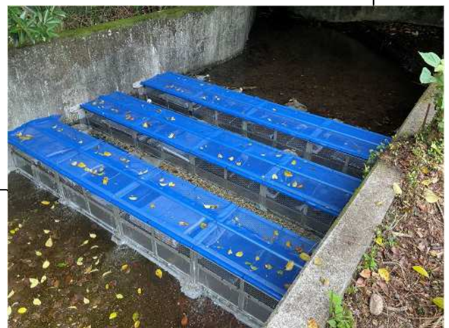
〔写真1〕 実証実験の様子
